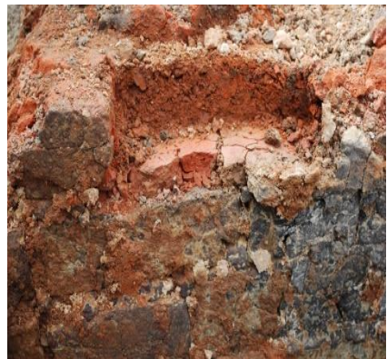
Nærbillede af bagvæggen. Den lysende røde farve skyldes den brændte lermørtel imellem stenene. De nederste sten er sammensintret til en mørkegrøn glasagtig masse.
