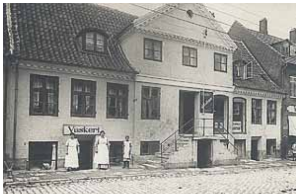
Hovedgaden 41 med den høje trappe. Det tidligere ting- og arresthus for Hørsholm Distrikt. Opført 1925, vaskeri i kælderen, skrædderi i den høje stue. Datering 1916.
