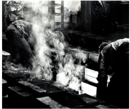
Foto: Sidste støbning på Hørsholm Jernstøberi, 23.12.1965.
