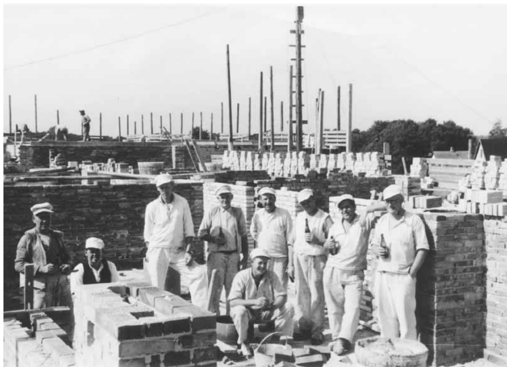
Håndværkere og arbejdsmænd i en pause under byggeriet af Arbejdernes almennyttige Boligselskabs byggeri, Frennevænget, på Ellevej i 1948. Det var den lokale entreprenør og tidligere konservative sognerådsformand, Alex I. Hansen, der stod for byggeriet. Hørsholm Egns Museums lokalarkiv.
